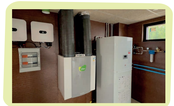
Sistema de Ventilación de la vivienda
