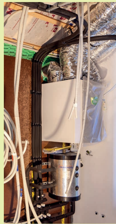
Sistema de Ventilación de la vivienda
