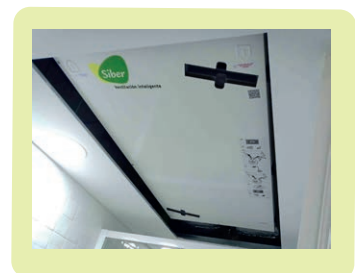
Sistema de Ventilación de Doble Flujo
